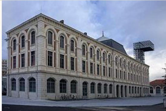
Bâtiment de l'horloge
